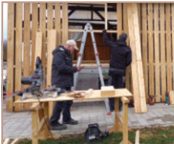
Umfangreiche Instandsetzungsmaßnahmen wurden mit Hilfe von zwei Firmen erfolgreich durchgeführt
